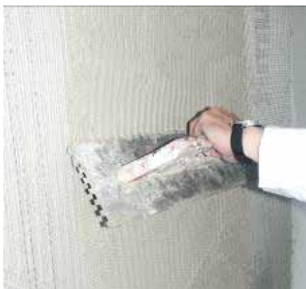
Ulaganje staklene mrežice u svježi sloj ljepila
