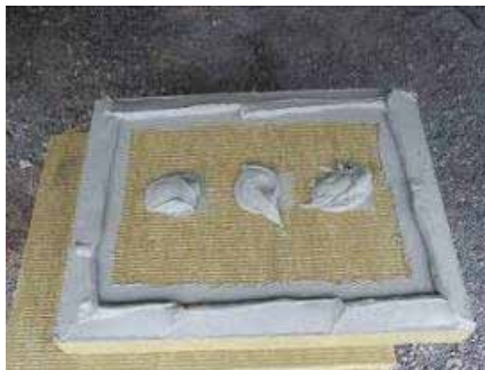
Nanošenje ljepila na ploče od EPS-a ili min. vune
