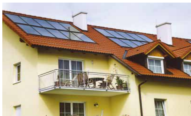
Kvalitetan pokrov i izvedba krovišta
