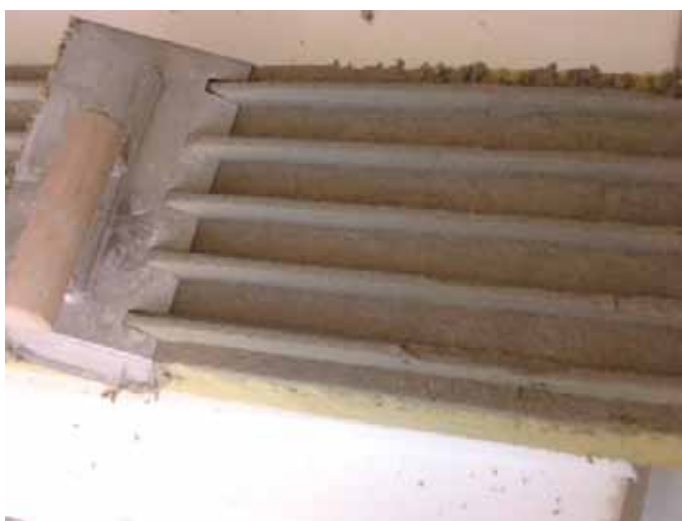
Nanošenje ljepila na lamele od mineralne vune
