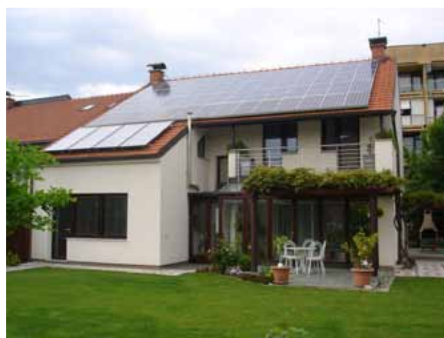
Slika 8. Solarni krov Špansko-Zagreb: gornji dio krova je prekriven s 56 fotonaponskih modula, a donji s 4 kolektora za toplinsku pretvorbu sunčeve energije.
