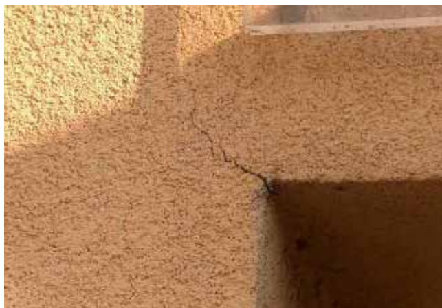
Slika: vrlo čest slučaj štete uslijed neadekvatnog armiranja sloja ljepila
