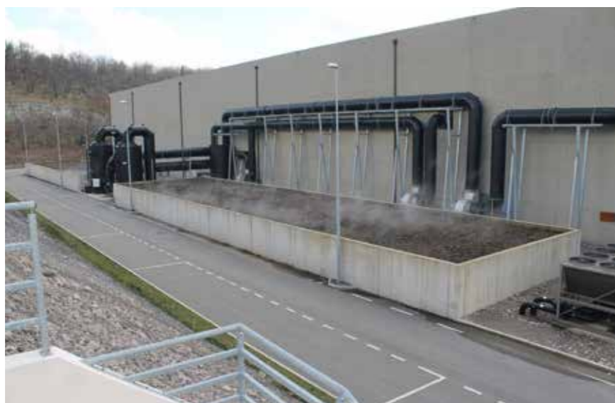
Centri moraju imati funkcionalne biofiltere u kojima se odvija proces čišćenja hlapljivih spojeva iz otpadnih plinova (neugodni mirisi)
